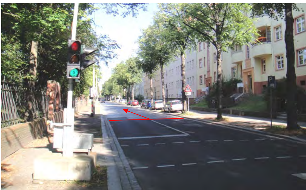
Foto: Straßenraum der Reichertstraße (Beginn des Pflasters ab roter Linie)
