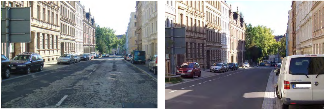
Fotos: Rauschwalder Straße, links vor Sanierung (Pflasterbelag mit schadhafte bituminösen Ausbesserungsstellen), rechts nach Sanierung (ebener Asphaltbelag und Schutzstreifen für den Radverkehr)
