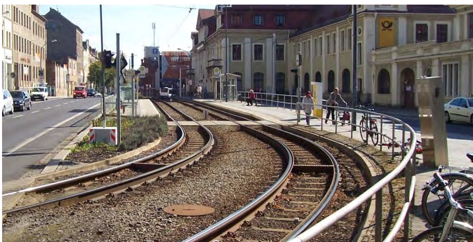
Foto: Straßenbahngleise in Schotterbauweise vor dem Bahnhof Görlitz
