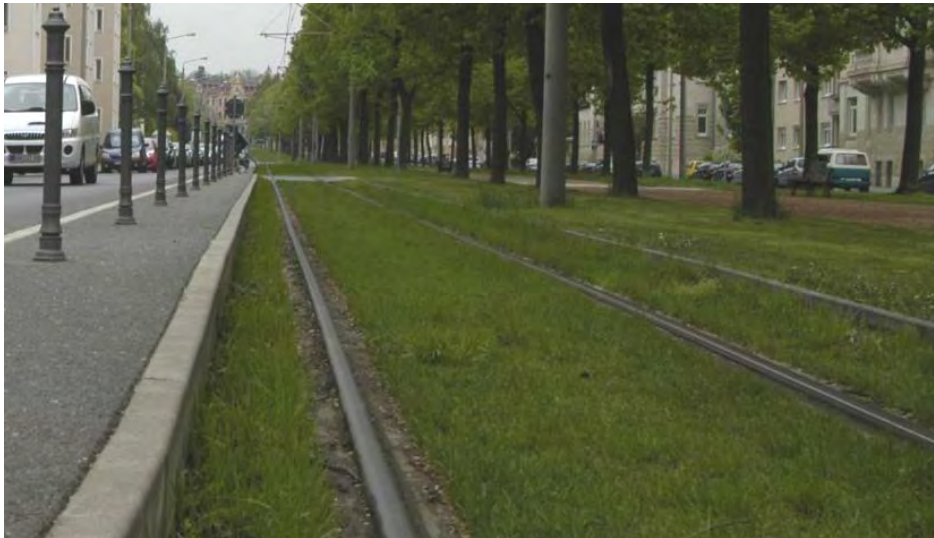
Foto: Beispiel für die Verlegung von Straßenbahnschienen als Rasengleis (Dresden)
